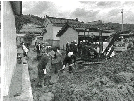
重機作業が出来ない所の土砂寄せの様子
